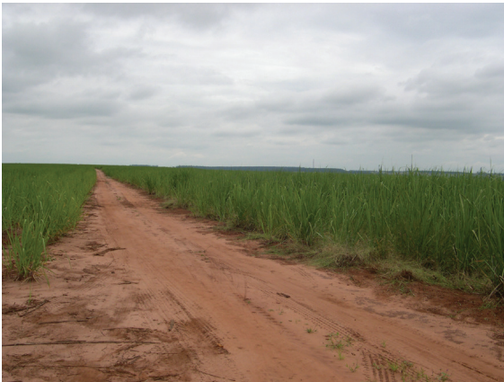
Figura 5 Estrada de terra sem tratamento superficial.
