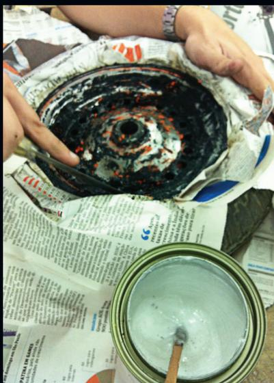
**Figura 11** Remoção de camada de tinta com removedor químico pastoso.
