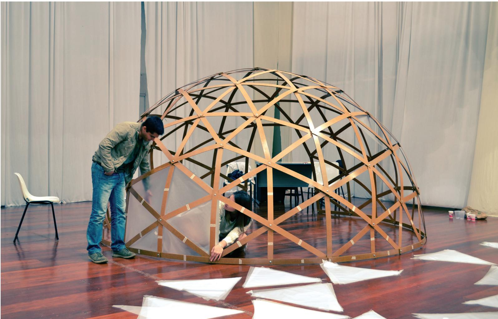
Figura 1: Montagem da estrutura geodésica.
