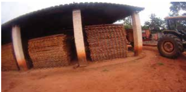
Figura 19- Centro de estocagem Fonte: o Autor
