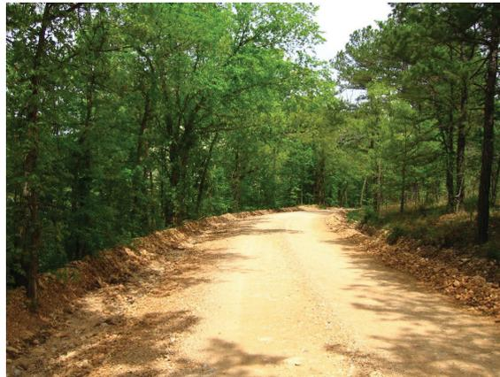
**Figura 6** Estrada de terra com superfície cascalhada.
