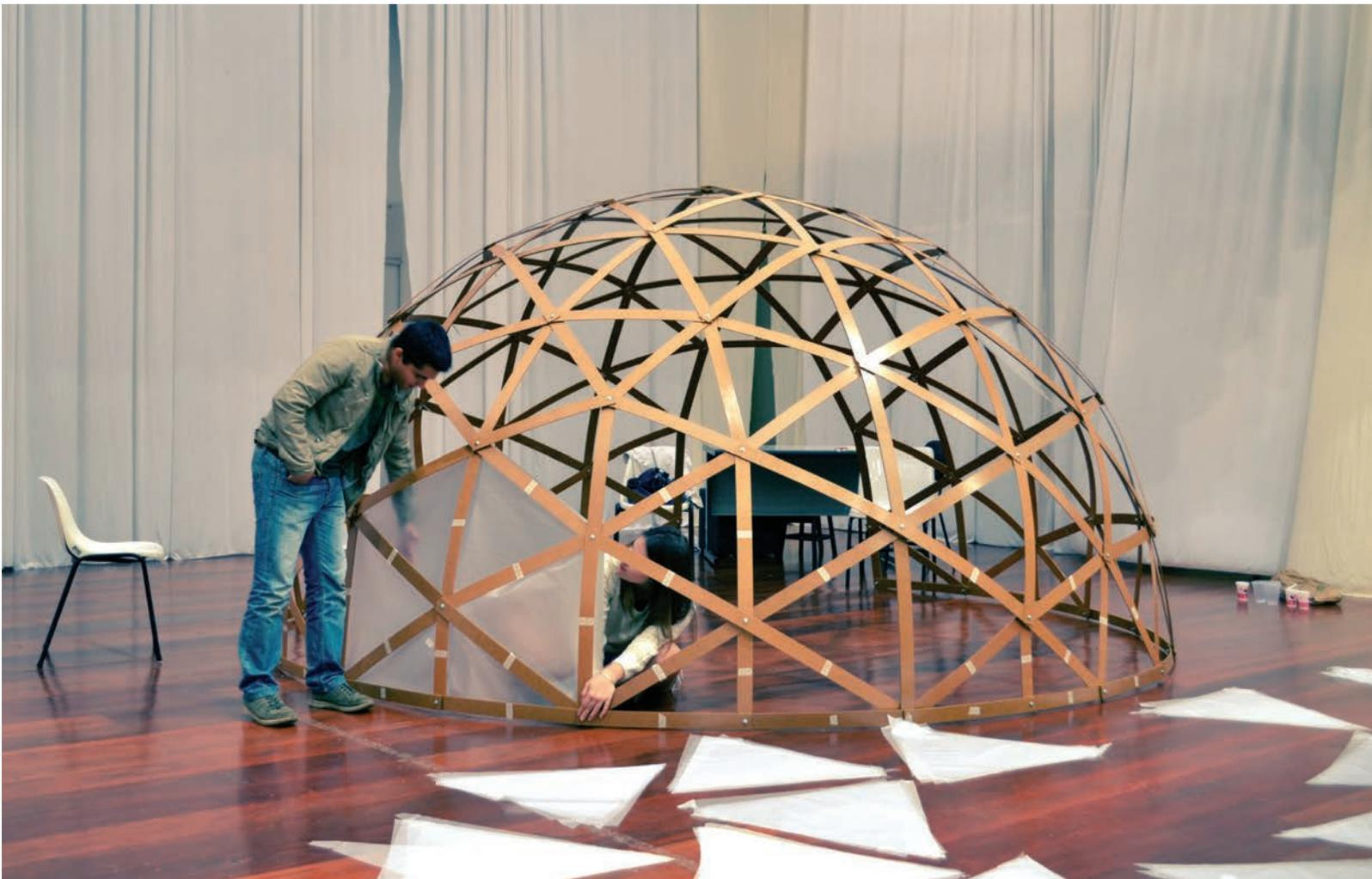
Figura 1: Montagem da estrutura geodésica.
